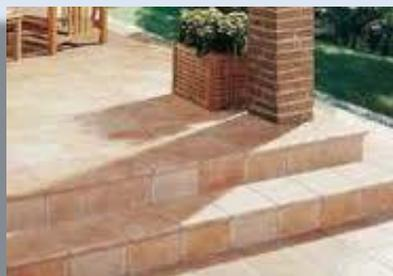
**Pavimentazione dei marciapiedi, e portici.** Eseguita in piastrelle di grès porcellanato posate con colla antigeliva come da indicazioni della Direzione dei lavori su massetto in malta cementizia e sigillatura degli interstizi con boiaccia di cemento o stucco (se compresi). Per pose in diagonale o lavorazioni particolari ci sarà una voce extra capitolato.
